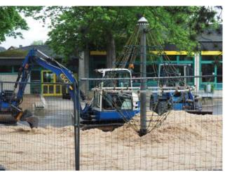
4. Nun wurden weiche Sägespäne hineingefüllt. Die Bagger mussten dann noch alles verteilen.
